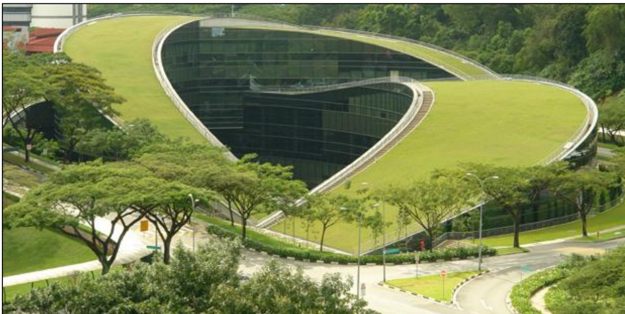
6. ábra A szingapúri Műszaki Egyetem (Nanyang Technological University) zöld teteje (Forrás: http://www.greenroofs.com/projects/pview.php?id=846 )
