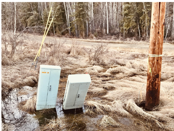
A permafroszt olvadása miatt fellazult talajban elbillent elektromos kapcsolószekrények, Alaszka Forrás: istockphoto.com
